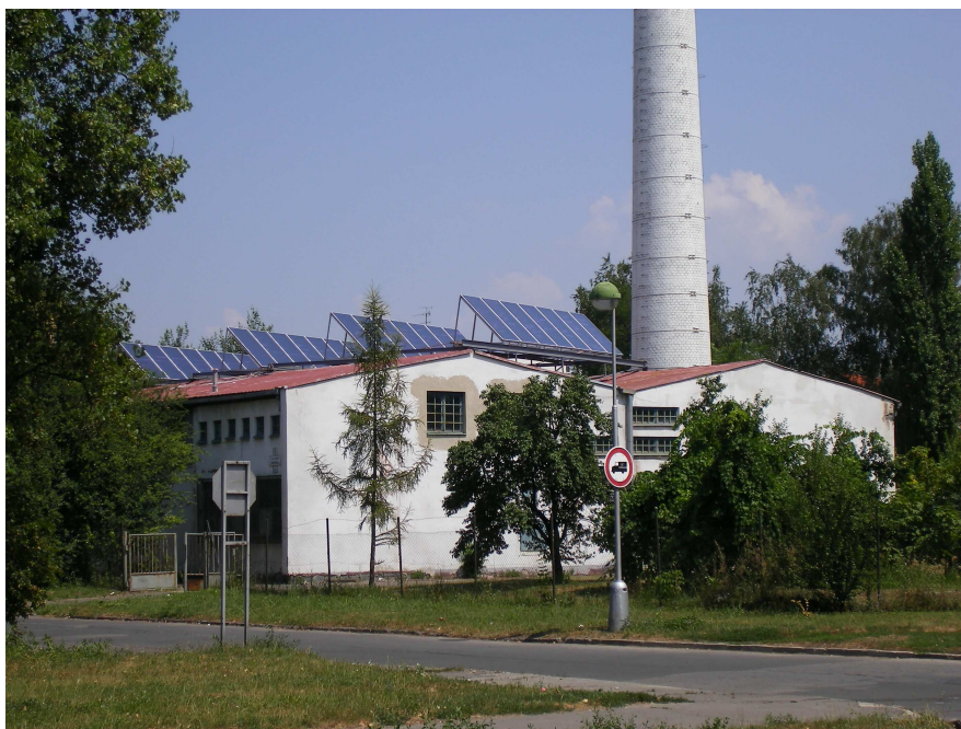
Obr. 8-1 Pohľad na inštalované solárne kolektory na OST spoločnosti COM-therm
